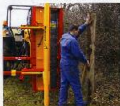
Colocar la malla en el poste
